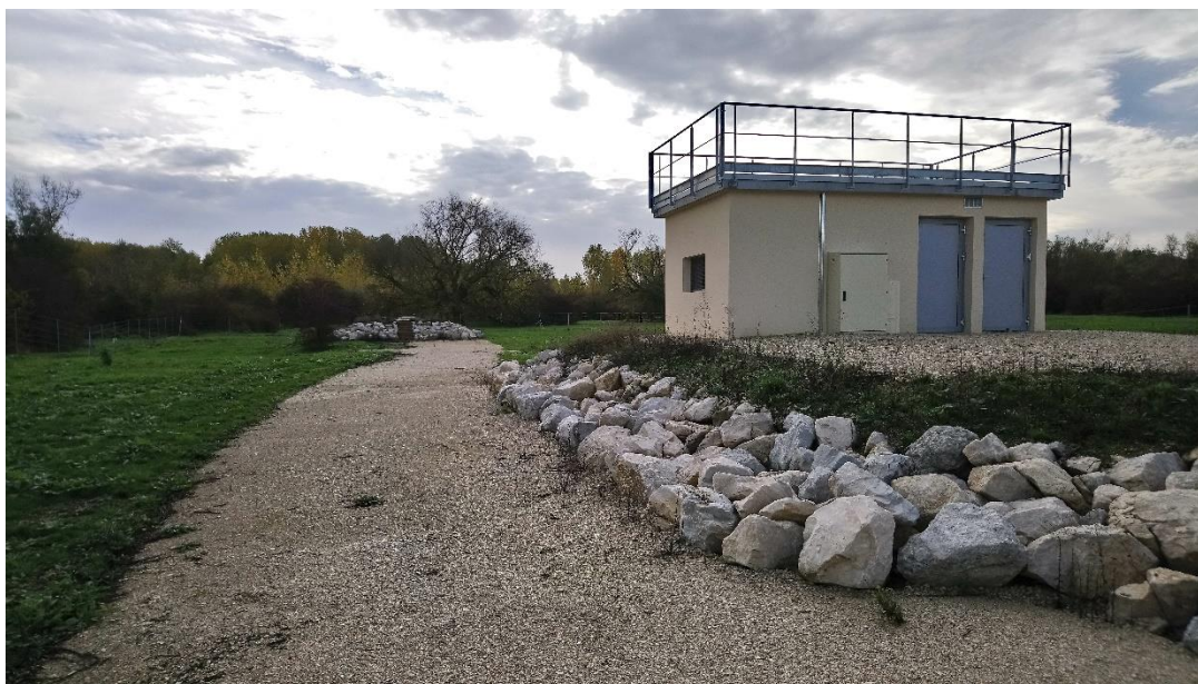
Figure 6 : Ouvrages de génie-civil (Fa au fond, Fb dans la station de pompage).
