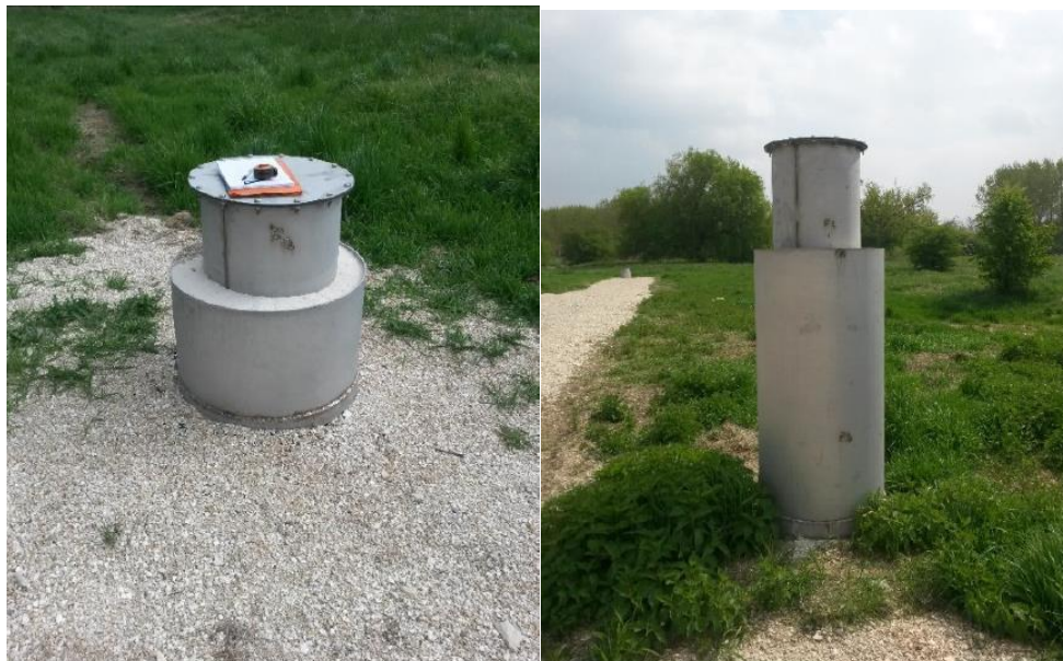
Figure 5 : Tête des forages BSS002PRVG/Fa à gauche et BSS002PRVF/Fb à droite
